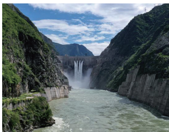
这是雅砻江流域水电开发有限公司开发建设运营的锦屏一级水电站。
